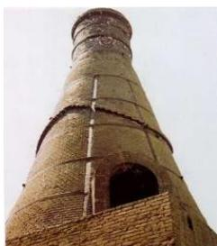
明治14年、小野田セメント製造会社（現・太平洋セメント株式会社）が創立され、明治16年から焼成炉4基の窯によって生産が始まりました。高さ9.6m、煉瓦を積み上げて作った立窯で、徳利に似ていることから「徳利窯」と呼ばれるようになりました。日本近代の洋式セメント製造法を伝える唯一の遺構で、重要文化財に指定されています。
