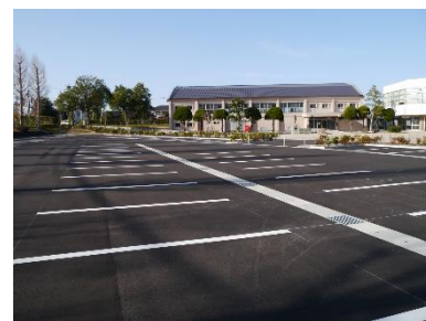
中央棟西駐車場
