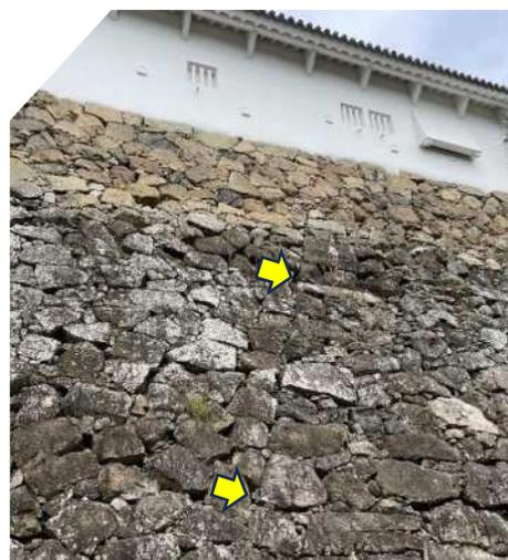
写真2. 石垣の継ぎ目(黄色矢印)が線として見える。線は石垣の角。右側が豊臣、左が徳川時代とされる。
