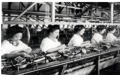
かつての富岡製糸場での作業の様子
