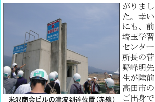
米沢商会ビルの津波到達位置(赤線)
