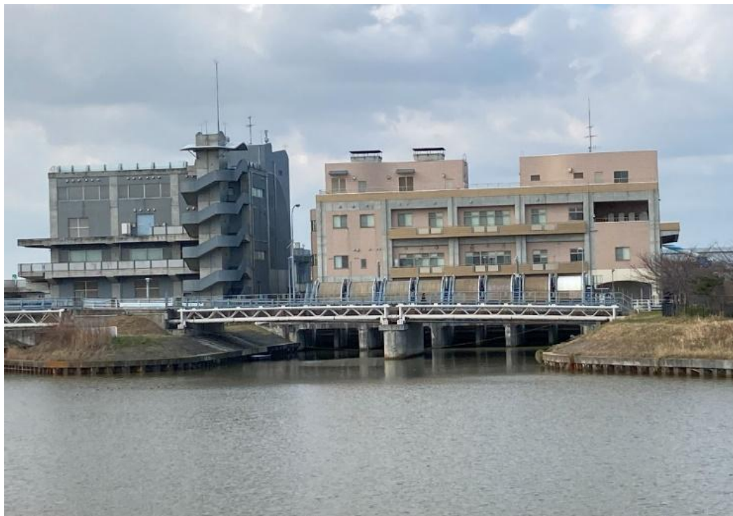
親松排水機場
