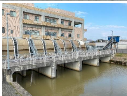
鳥屋野瀉排水機場
