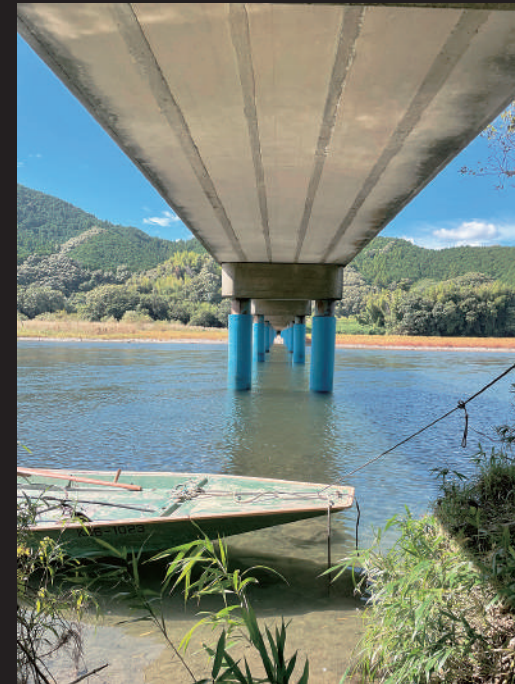
沈下橋 北島 靖 卒業生
