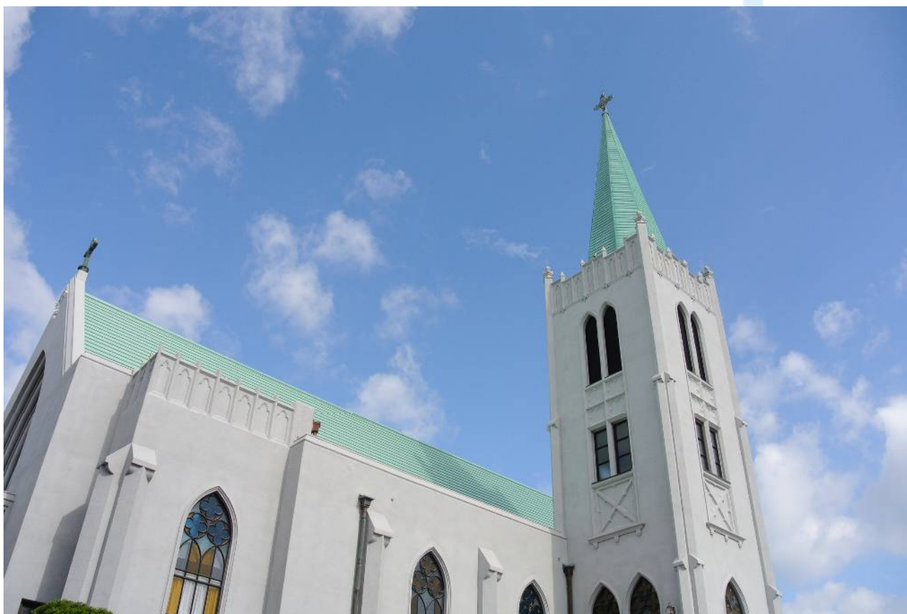
カトリック山手教会：1988 年に横浜市の歴史的建造物に認定。現在の聖堂は関東大震災後に献堂されたものです。
