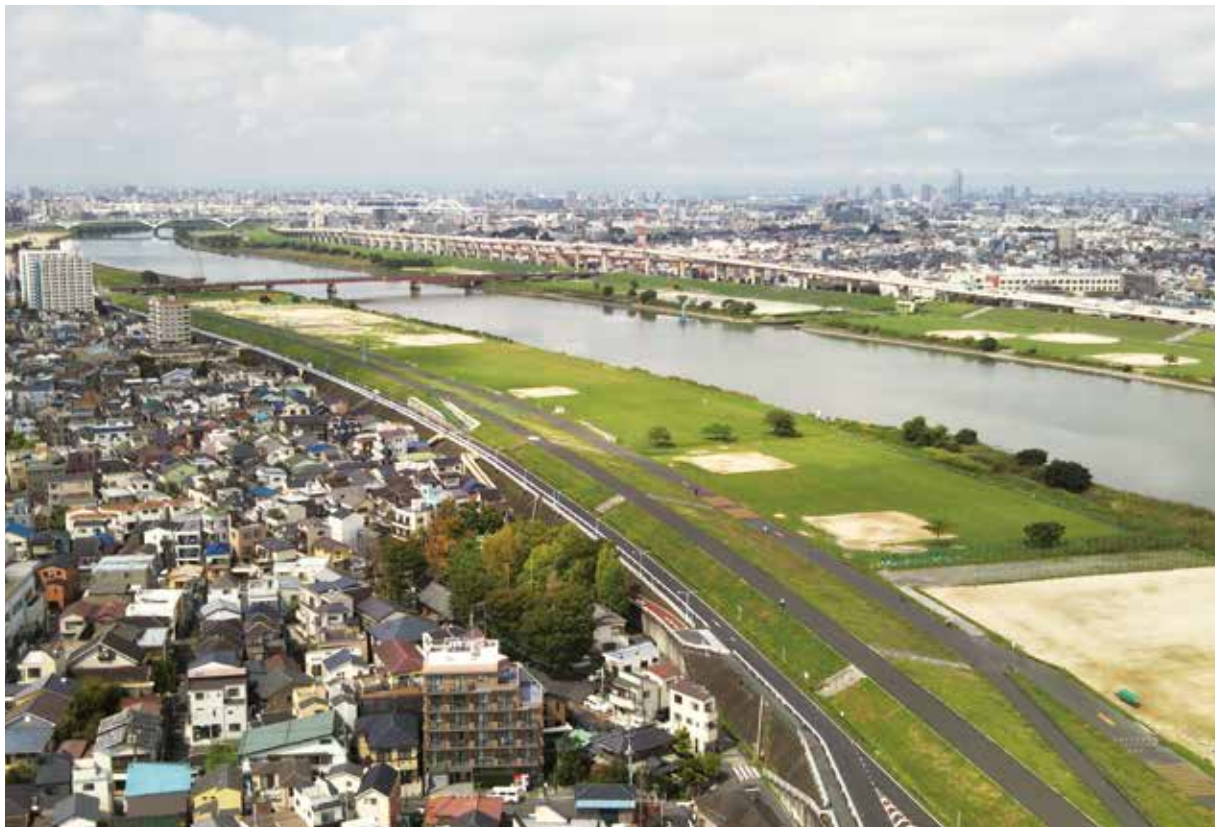
荒川・学びピア21屋上より 令和2年8月撮影
